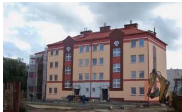
Budynek wielorodzinny LTBS ul.Łasaka
