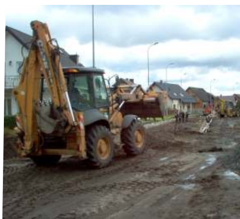
Budowa ulicy Wielkopolskiej
