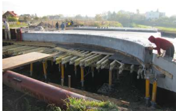
Most na rz. Okalicy (w budowie)
