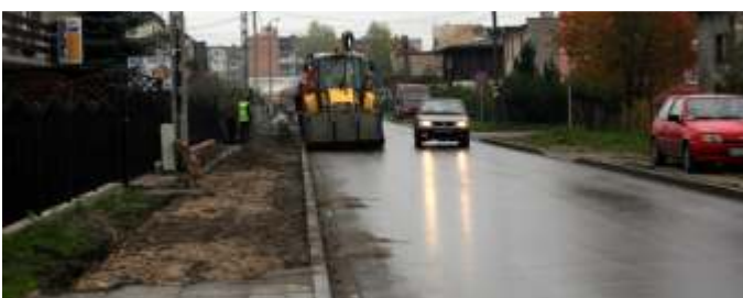
Budowa ul.Topolowej (etap 1)
