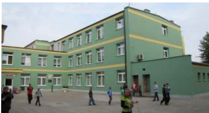
Szkoła Podstawowa nr 8 - nowa elewacja
